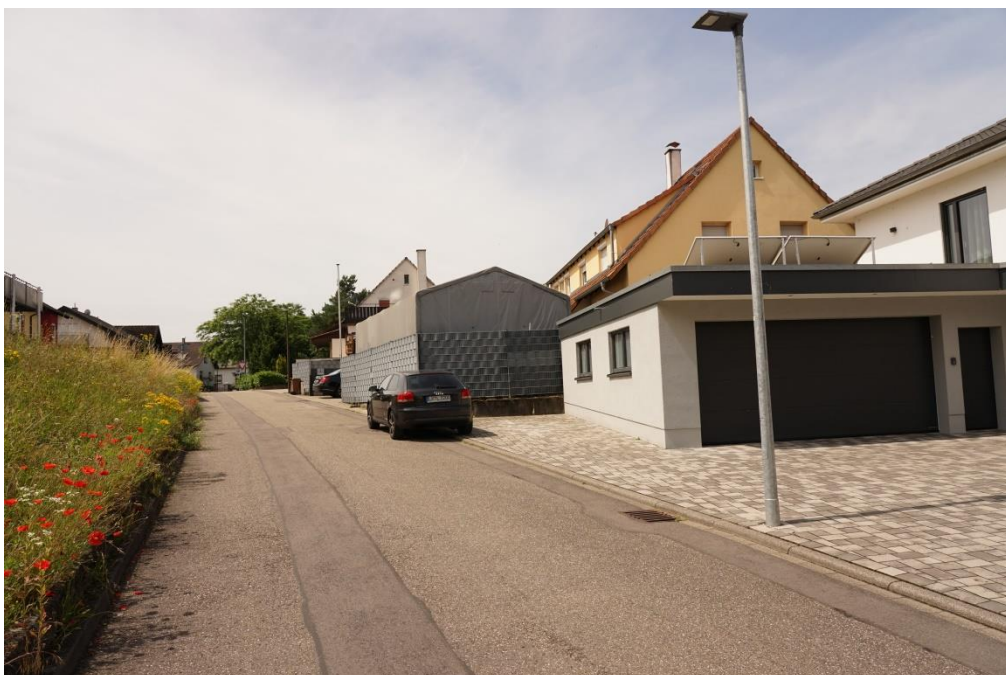
Bild 4: Gut sanierte Gebäude in der Westendstraße
